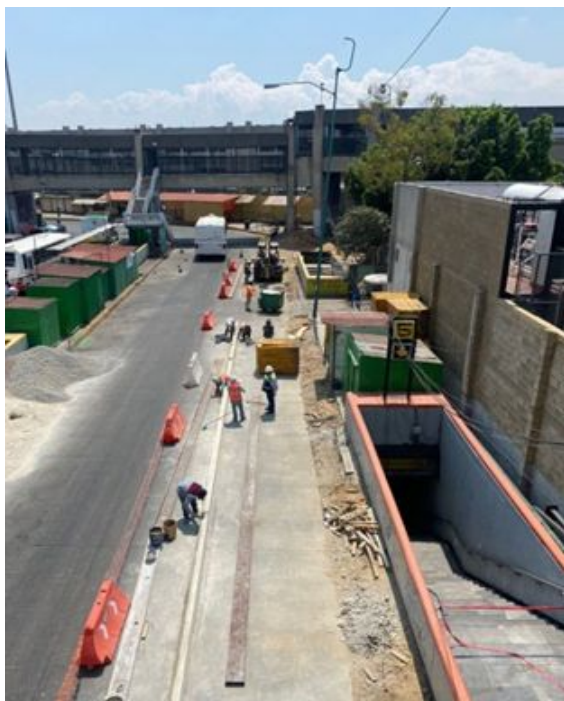
Obras en andén A
