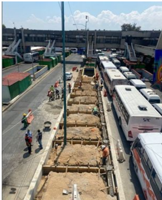
Obras en andén H
