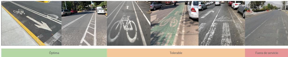
Figura 3.1. Ejemplo de estado de conservación de marcas en pavimento. (SEMOVI, 2024)
