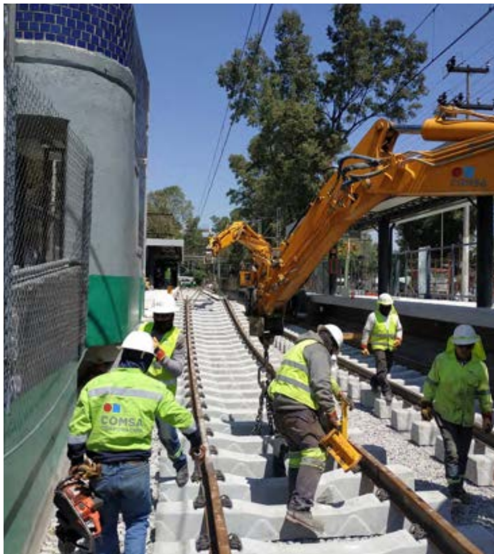
Trabajos de modernización
