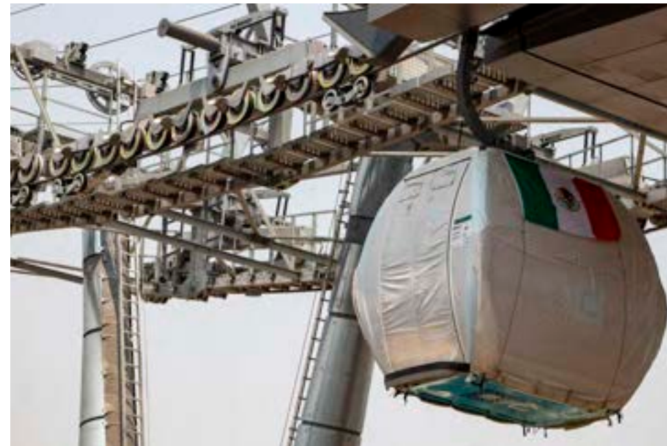
Pruebas operativas Cablebús Línea 3
