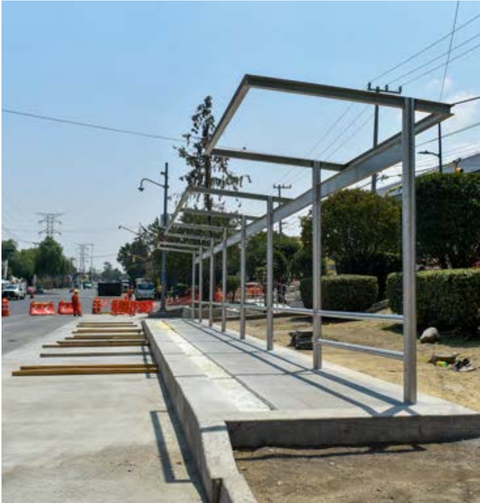
Obras en Av. Aztecas
