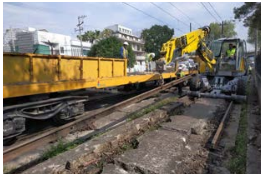
Estado de las vías antes de la modernización
