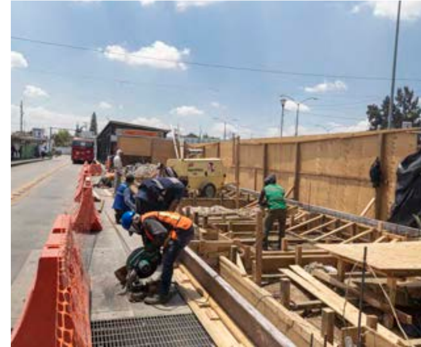
Obra CETRAM Pantitlán
