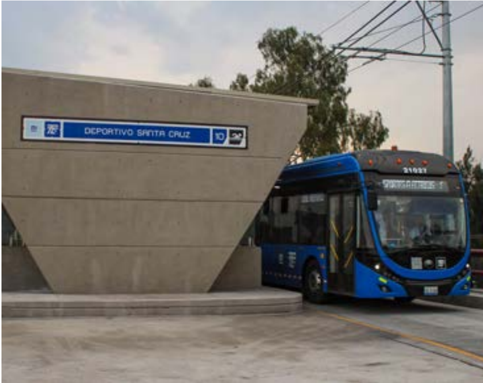
Estación Deportivo Santa Cruz
