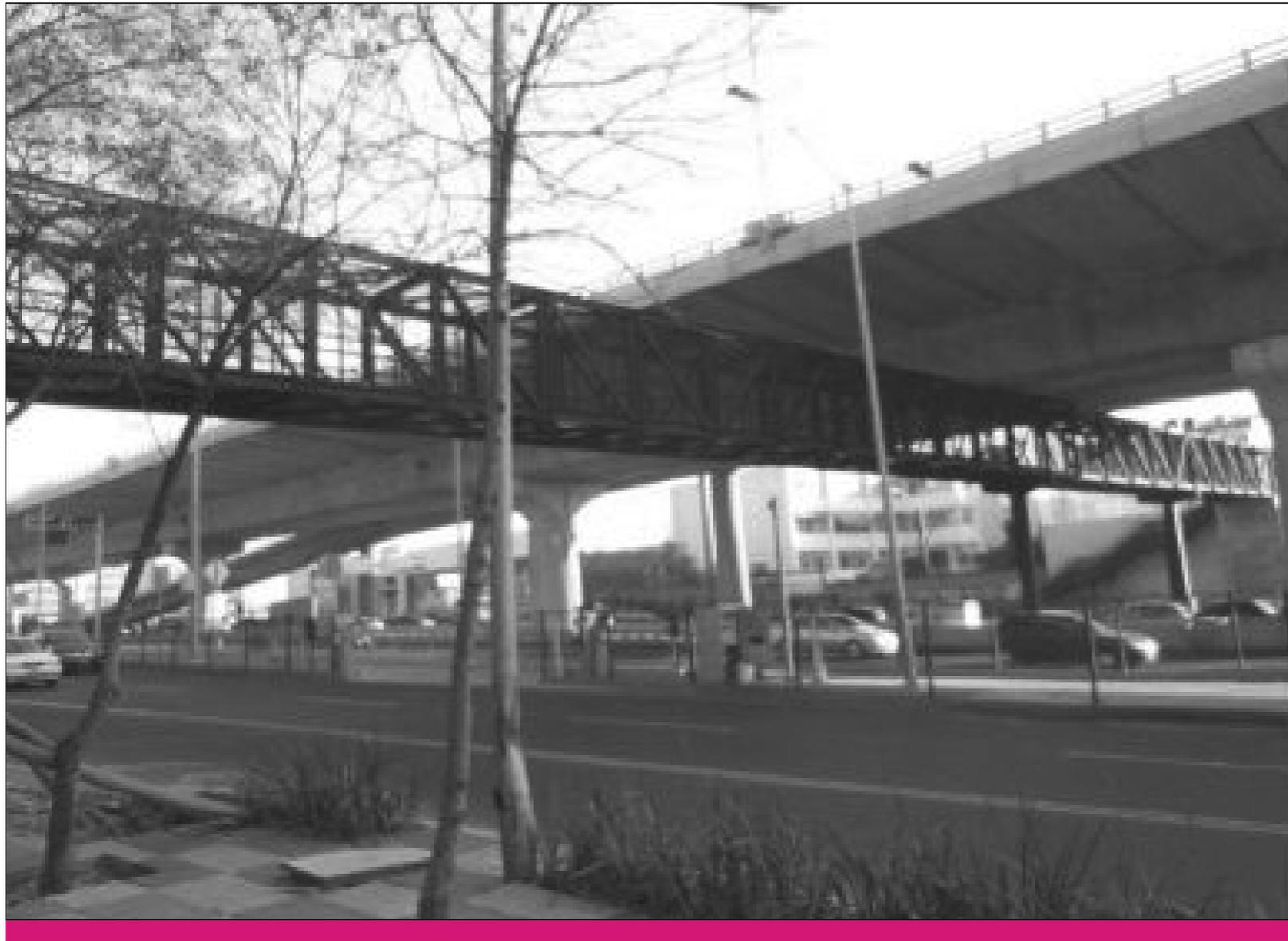
En la Autopista Urbana Norte se terminó la construcción de 4 puentes peatonales con estructura metálica y de concreto con rampas de acceso para personas en silla de ruedas; acciones que mejoran la movilidad y seguridad peatonal en cruces del Anillo Periférico en las intersecciones con las calles General Las Huertas, General Sóstenes Rocha, General José Morán y del Museo Tecnológico que comunica a la estación del Metro Constituyentes y la Segunda Sección del Bosque de Chapultepec.
