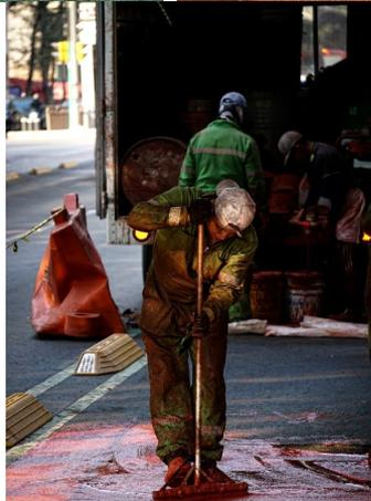
→ **MICROCARPETA ASFÁLTICA.**- Aplicación manual de microcarpeta *slurry seal* con color integrado.
